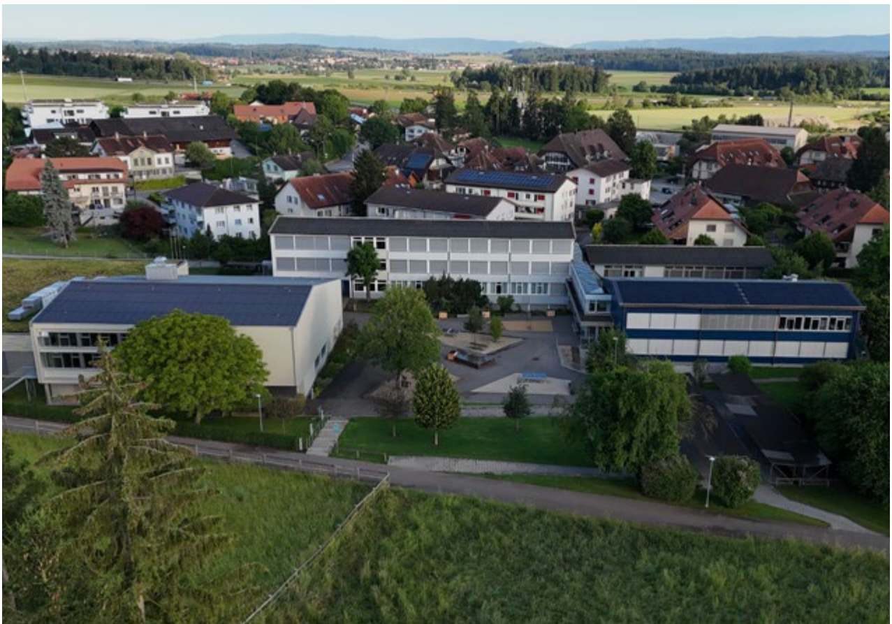
Schulanlage mit sanierter Gebäudehülle OS
